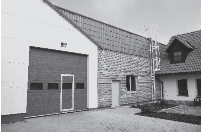
Výrobní hala firmy Design Weld s.r.o. Rohoznice
