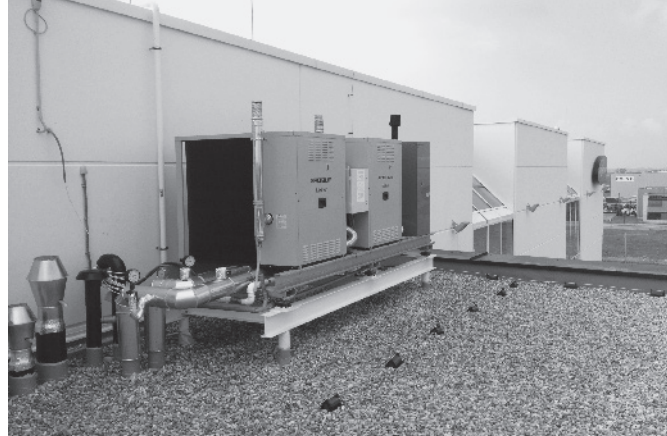
Skladovací hala Hagleitner Hygiene Slovensko, s.r.o. Senec
