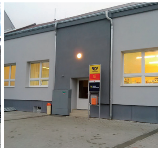
Stav budovy po rekonstrukci s plynovým tepelným čerpadlem ROBUR K18.
