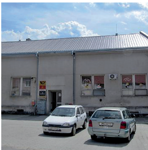
Stav před výměnou zdroje: levá část objektu – plynový závěsný kotel s odkouřením na fasádu, pravá část objektu – tři parapetní plynové jednotky.
